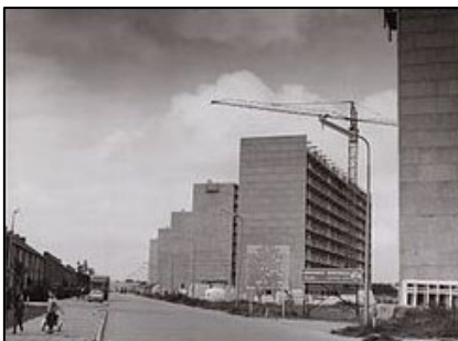
De bouw van de Meteorenflats, 1968
