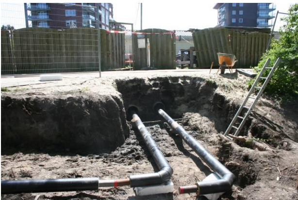
Nieuwe aanvoerleidingen van de stadsverwarming door de dijk
