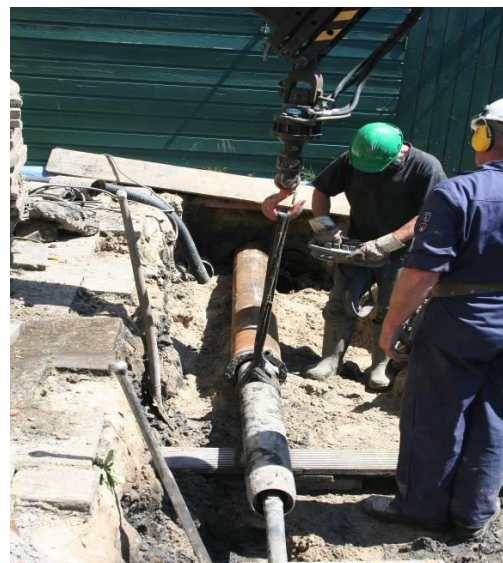
Aanbrengen van mantelbuizen onder schuren
