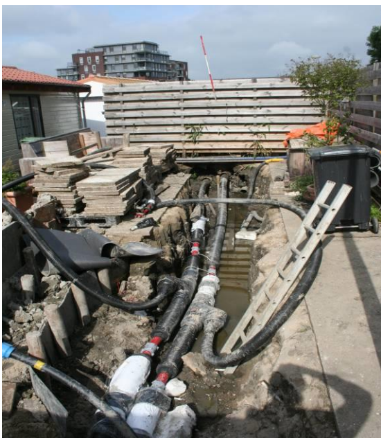
Nieuwe stadsverwarmingleidingen met aftakkingen
